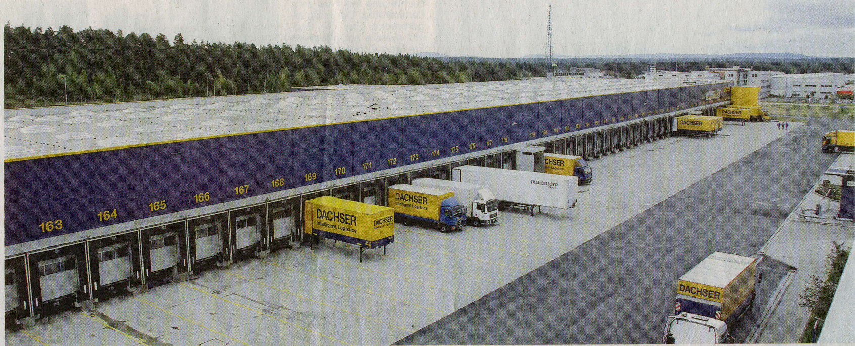
Das neue Logistikzentrum der Firma Dachser: An 188 Toren werden Waren aufgenommen und abgeladen.
